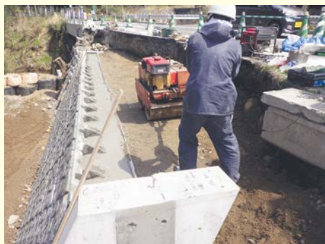
進捗中の復旧工事
